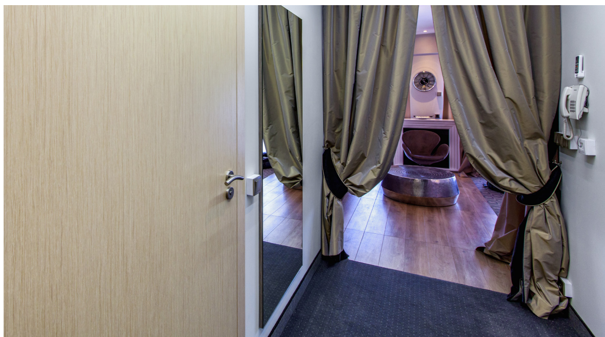
drzwi EI30 PLUS jednoskrzydłowe, ościeżnica stała drewniana
